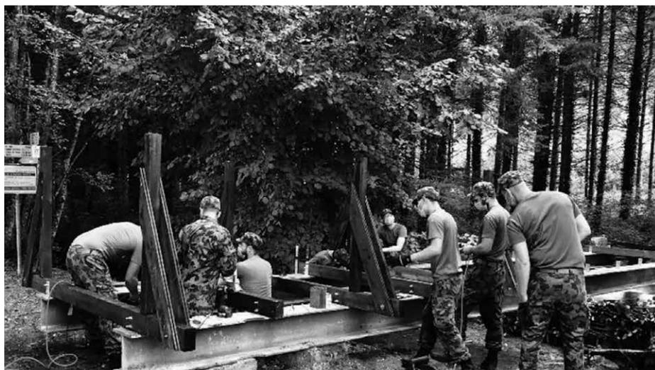
*Montage de la superstructure de la nouvelle passerelle par des sapeurs du bataillon du génie 2.*
